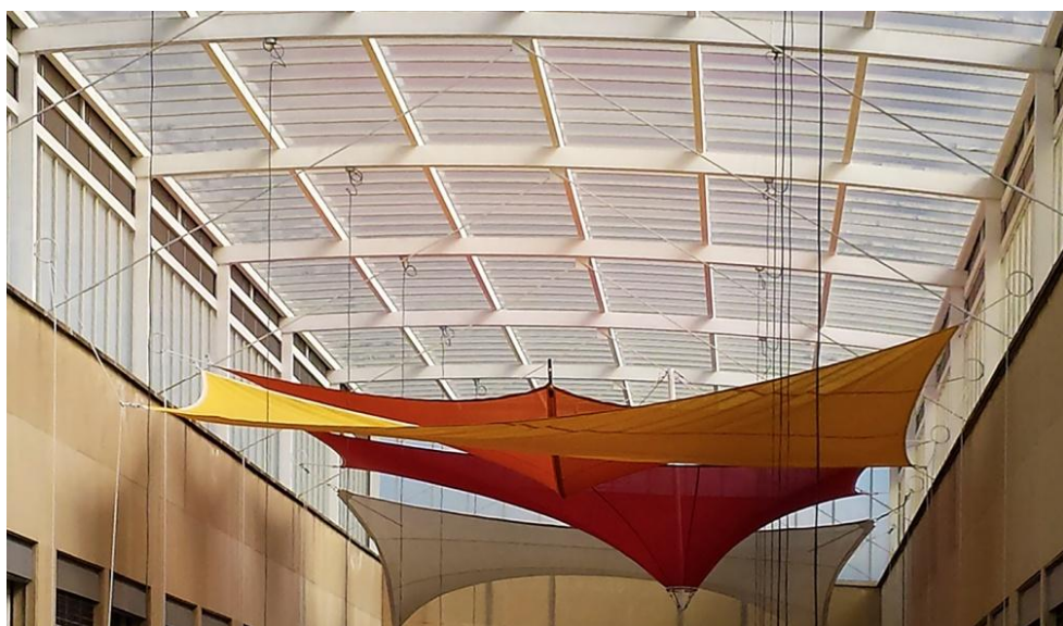
Figura 7. Cubierta de policarbonato del edificio de Arquitectura Pabellón Nuevo
