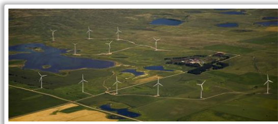
Parque eólico de Tatanka (EE.UU)
