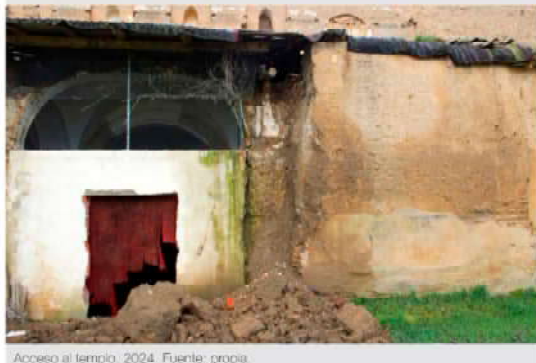
Acceso al templo. 2024. Fuente: propia.
