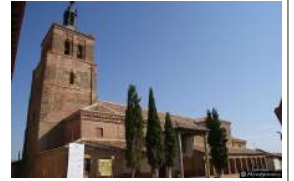
Figura 9. Iglesia de San Facundo y San Primitivo en Cisneros, Palencia. Foto G. Rodicio Rodríguez.
