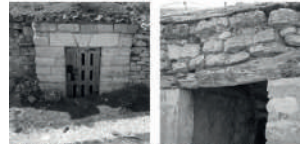
Fig. 10. Ayuntamiento de Baltanás. Cornisa típica de la bodega. Fotografía (Archivo Ayuntamiento de Baltanás)
