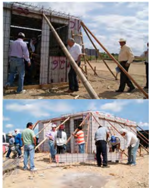
Foto No. 4 y No. 5: Sistema constructivo MUROTEC, Programa habitacional 'Ciudad Victoria': Viviendas Fuente: Banco Ecuatoriano de la Vivienda (BEV), marzo 2011
