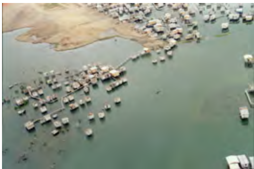
Foto 6. Avance progresivo de viviendas sobre los esteros, condenados inexorablemente a su desaparición.
