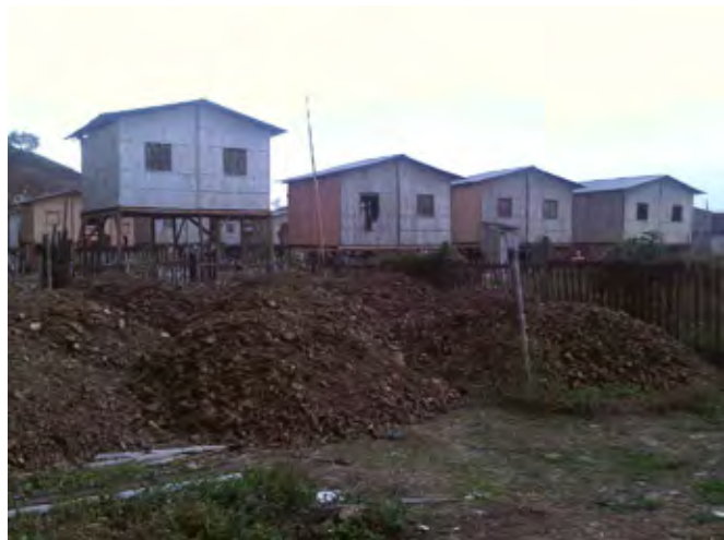
Foto 5: Viviendas Hogar de Cristo, Sector Monte Sinaí Fuente: Arq. Enrique Mora
