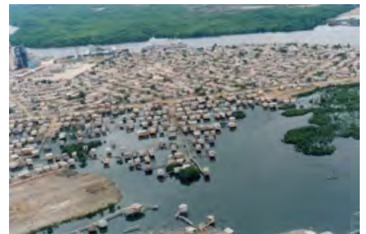
Foto 8. Evidente imagen de inestabilidad estructural-constructiva y social.
